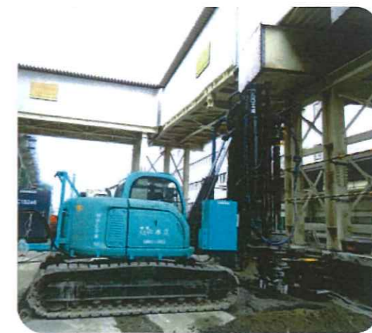
低空頭の施工状況
