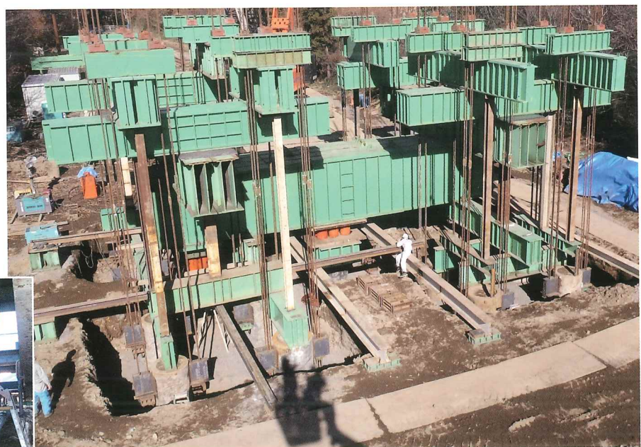
6500KNの載荷試験(H・B・M工法)
