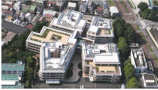
東京都某特別養護老人ホーム (2014年7月) 住 所 東京都板橋区 工 法 プレボーリング拡大根固め工法 杭 径 \phi 5060 \sim \phi 8095 杭 長 26m~32m
