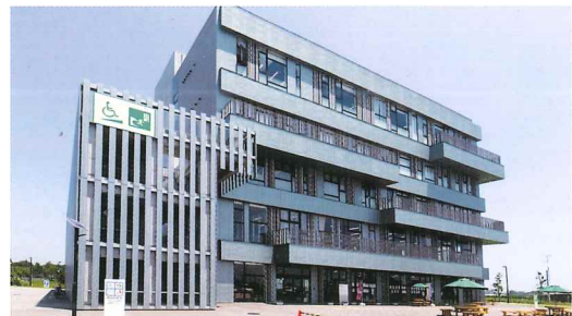
蓮沼交流センター (2018年1月) 住 所 千葉県山武市 工 法 プレボーリング拡大根固め工法 杭 径 \phi 400 \sim \phi 1000 杭 長 21m~30m
