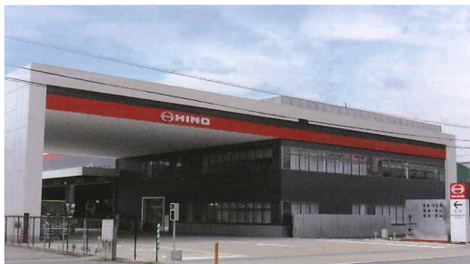
東京日野自動車 川口支店 (2017年12月) 住 所 埼玉県川口市 工 法 プレボーリング拡大根固め工法 杭 径 \phi 400 \sim \phi 4430 \sim \phi 800 \sim \phi 10080 杭 長 22m~23m
