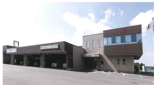
いなほ消防署 (2015年3月) 住 所 茨城県稲敷市 工 法 プレボーリング拡大根固め工法 杭 径 \phi 350 \sim \phi 600 杭 長 9m~15m
