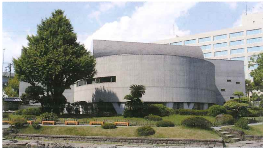
新刀剣博物館 (2017年8月) 住 所 東京都墨田区 工 法 プレボーリング拡大根固め工法 杭 径 \phi 400 \sim \phi 600 杭 長 34m~35m
