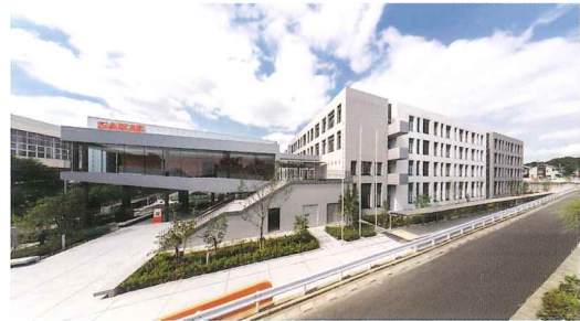
埼玉栄中学校・高等学校 (2016年7月) 住 所 埼玉県さいたま市 工 法 プレボーリング拡大根固め工法 杭 径 \phi 4050 \sim \phi 100120 杭 長 17m~18m
